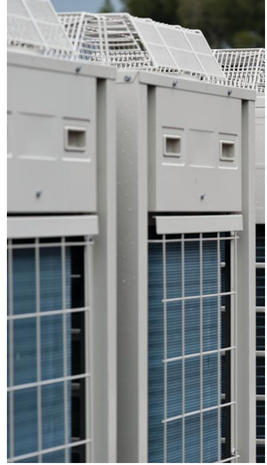
EIFFAGE ENERGIE ET EIFFAGE ENERGIE THERMIE OFİS BİNASI SÜREKLİ ISITMALI VRV IV İSİ POMPASI
